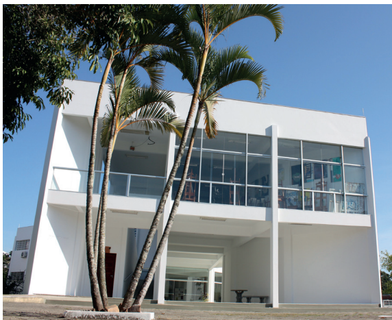
Galeria do DAV antes do fechamento com vidros Foto: Roberval Santos
